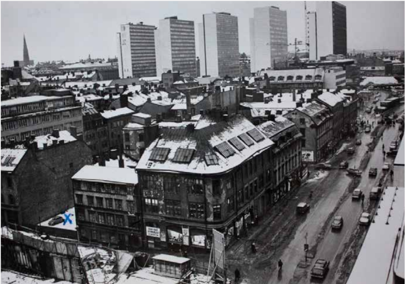
Befolkningen i Stockholms stadskärna halverades mellan 1942 och 1980. Vy över kvarteret Gripen i gamla Klara med de nybyggda Hötorgsskraporna i bakgrunden, tagen 1962 Klarabergsgatan. Upphov: Okänd. Stockholmskällan/Stockholms stadsarkiv.
