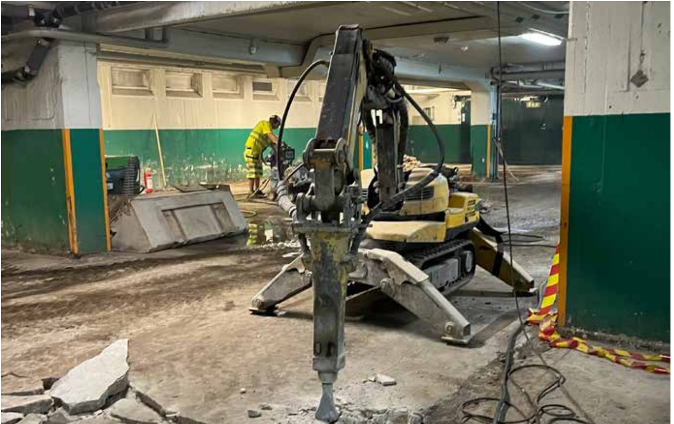
Reparation av betongskador i garage byggt på 1950-talet. Pågjutna betonglager med gamla tätskikt bilas bort från det bärande bjälklaget.
