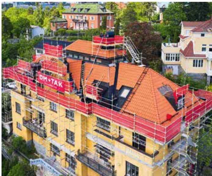
Pågående arbeten. Alpstigen, Stocksund.
