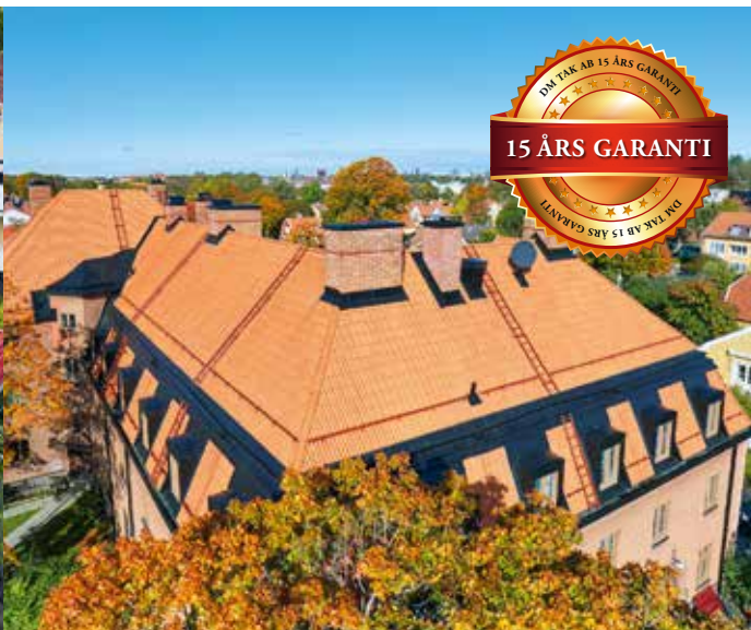
Färdigställda arbeten. Ulvsundavägen, Bromma.
