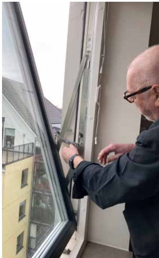
Lars Ottosson försöker säkra fönstret med hjälp av den lilla plastspärren.
