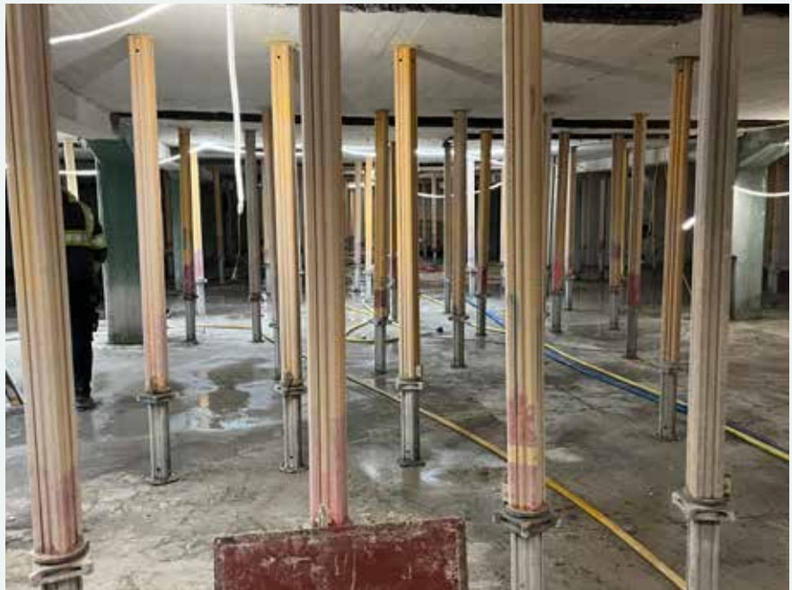
För att tillfälligt bära upp det enorma trycket från tio våningar fick man sätta in en mängd stöttor medan pelarna renoverades.
