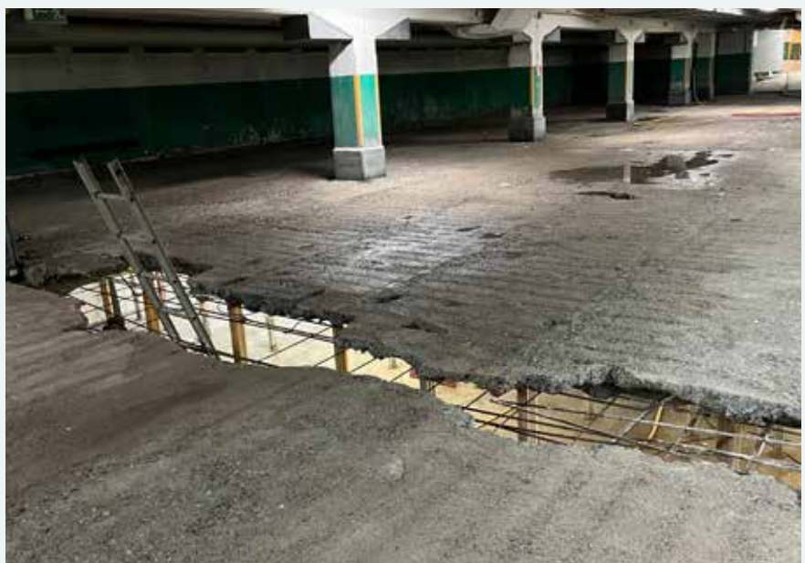
Man fick borra bort ett 25 centimeter tjockt lager av asfalt. Lager hade lagts på lager under årens gång.
