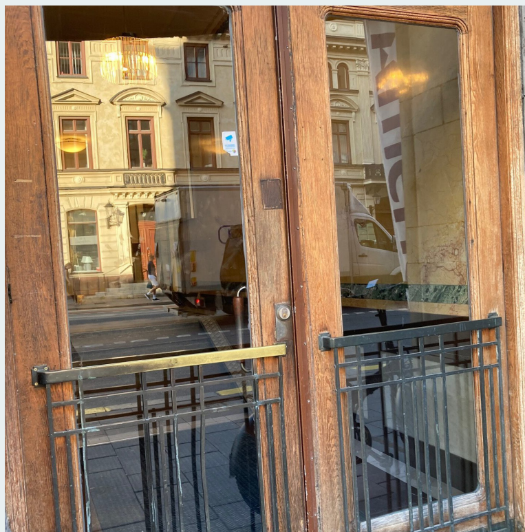
En sliten men vacker port. Den ger karaktär till hela fastigheten
