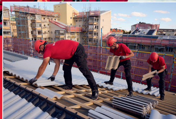
Omläggning av taken på Brf Ånghästen, Södermalm
