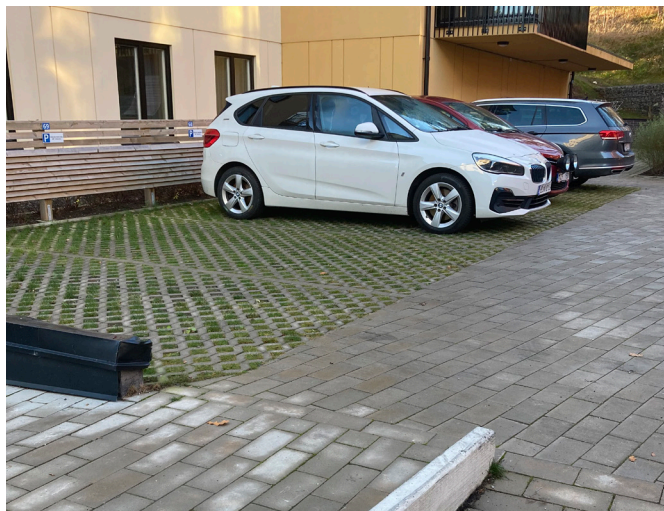
Gräsarmering är ett sätt att kombinera bärighet med möjligheter till låta vattnet absorberas på de gröna ytorna. Foto: Lars Svingdal.
