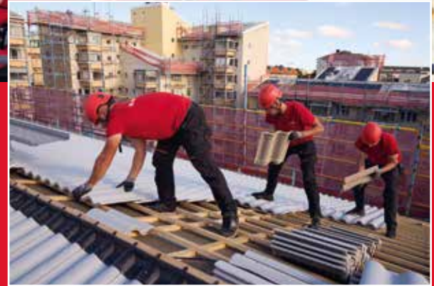
Omläggning av taken på Brf Ånghästen, Södermalm
