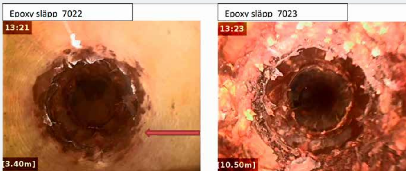
När avloppet filmades visade sig att hela avlopssystemet höll på att mer eller mindre rosta sönder. Foton från Fastfixarnas rapport.
