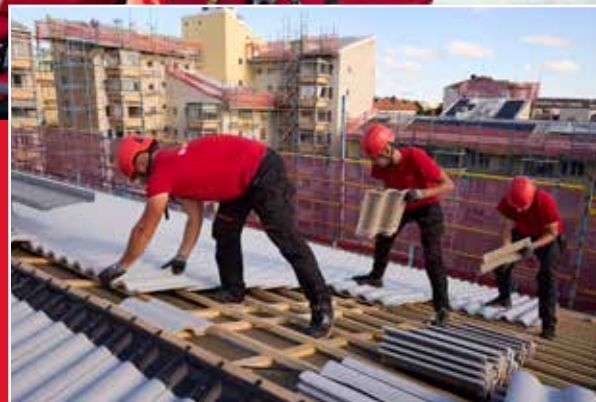
Omläggning av taken på Brf Änghästen, Södermalm
