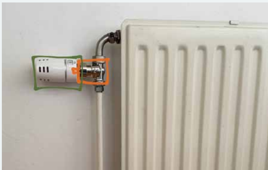
Det som är markerat med grönt är termostaten som reglerar ventilen, beroende på rumstemperaturen. Det gulmarkerade är ventilen som reglerar vattenflödet.
