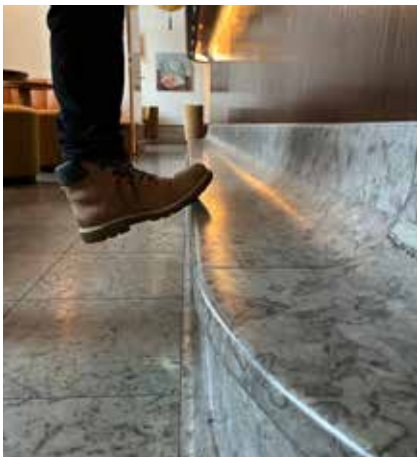
Foten på bardisken på Stockholms stadshotell är gjord av grå kalksten från Kinnekulle. Genom att också golvet är i kalksten blir effekten att baren liksom växer upp ut golvet.
