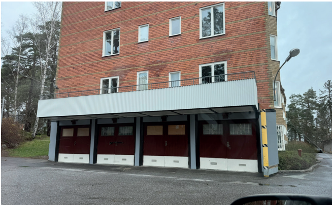
Den färdigrenoverade balkongen.
